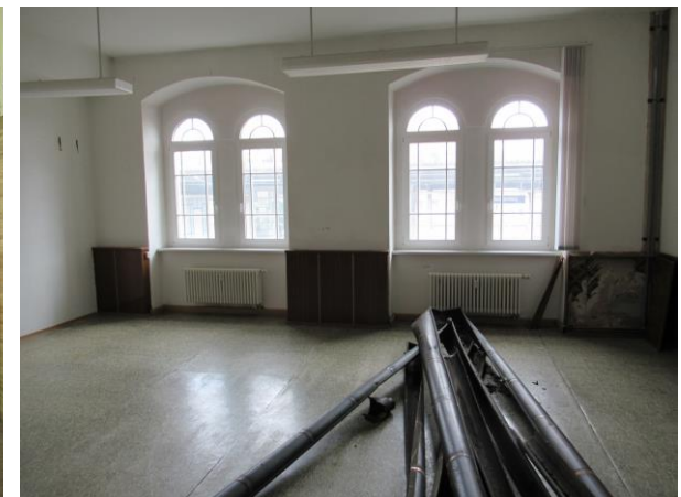
Innenräume im Obergeschoss
