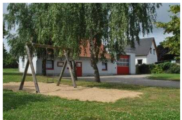
Feuerwehrgerätehaus in Veltheim
