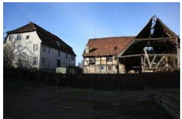
Gebäudebestand in der Schulstraße
