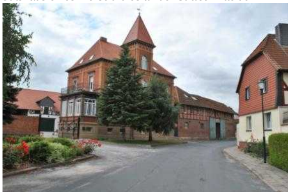
Gebäude an der Straße Kliebe
