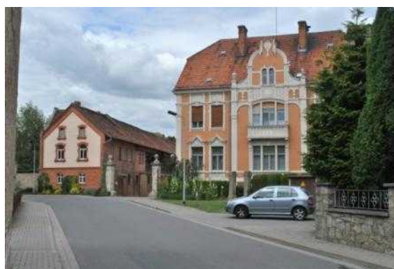
Gutshaus eines großen Vierseithofes an der Ernst-Thälmann-Straße
