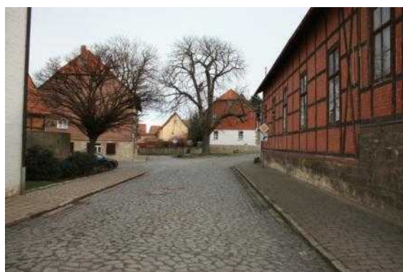
Blick in die Straße Westerntor
