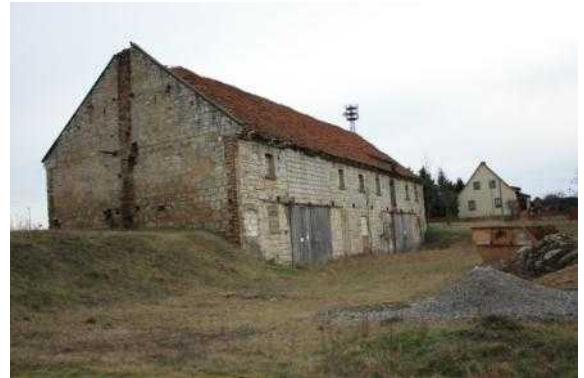
Verfallene Scheune im zentralen Bereich des Siedlungssplitters
