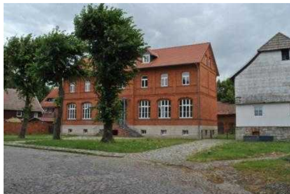
Gebäude an der Straße Kliebe
